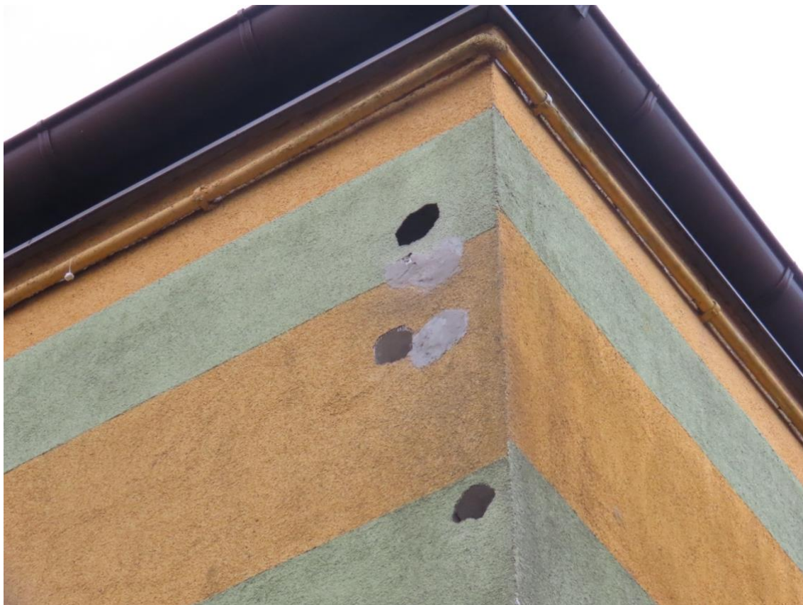
Fot. 11. Elewacja od strony boiska - otwory w elewacji, miejsca gniazdowania ptaków. Fot. B. Lesner
