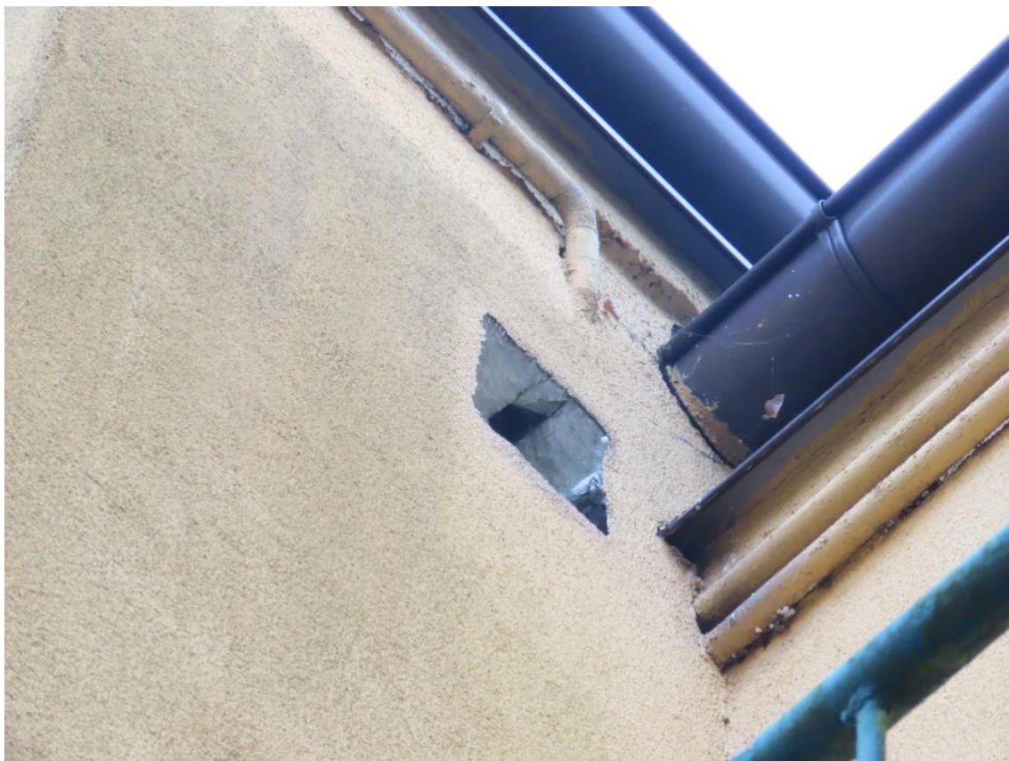
Fot. 9. Elewacja budynku od strony boiska – otwór wentylacyjny z wyrwaną kratką. Fot. B. Lesner
