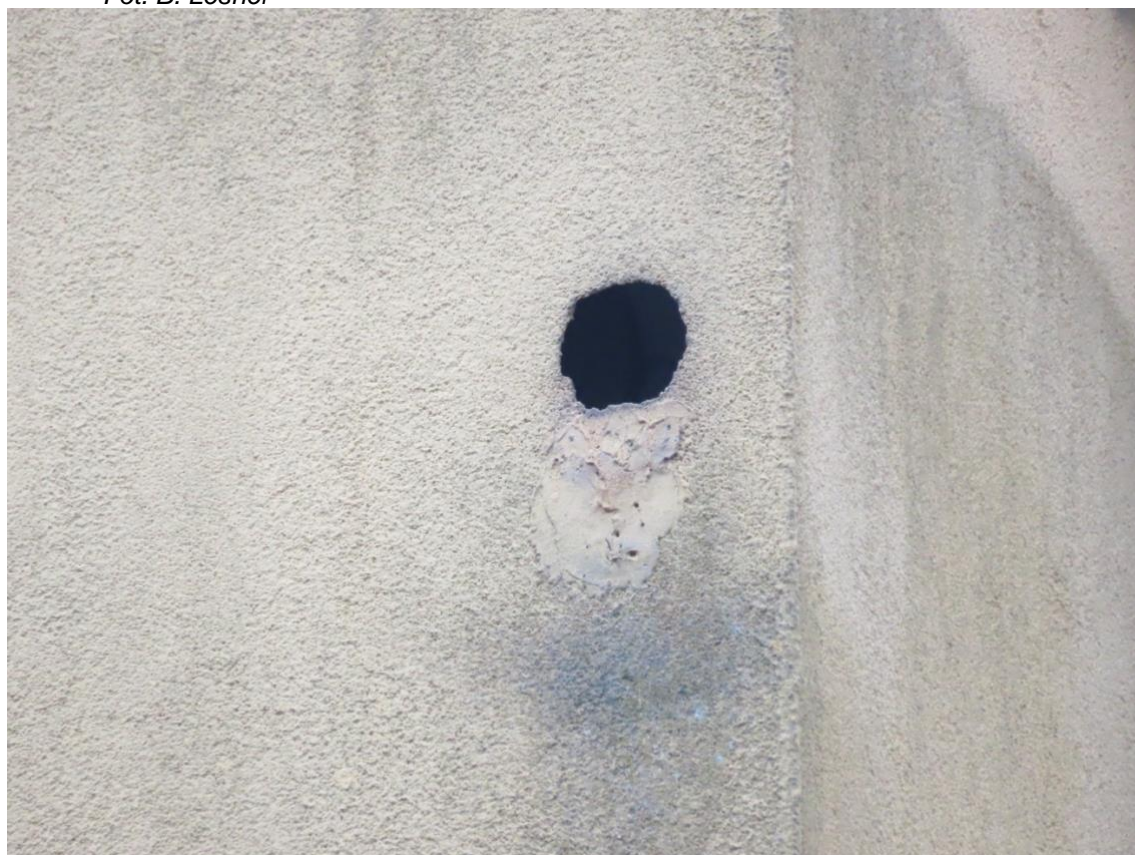
Fot. 14. Elewacja od strony ulicy - otwory w elewacji ze śladami siadania ptaków. Fot. B. Lesner
