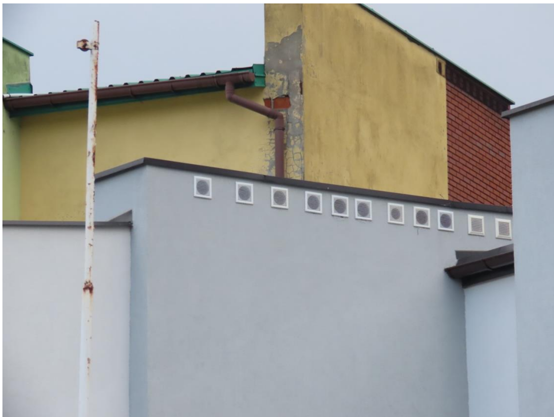
Fot. 23. Sala gimnastyczna od strony boiska – zasłonięte otwory wentylacyjne. Fot. B. Lesner
