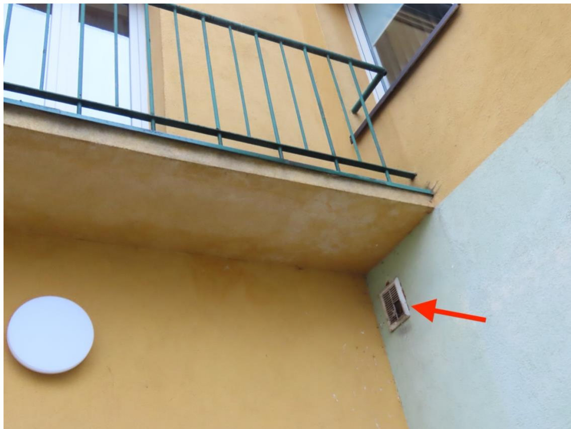
Fot. 8. Elewacja budynku od strony boiska – otwór wentylacyjny z częściowo wyrwaną kratką i śladami gniazdowania ptaków. Fot. B. Lesner
